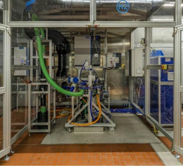
Abbildung 1: Das neue Labor zum Betrieb von Brennstoffzellen mit Wasserstoff
